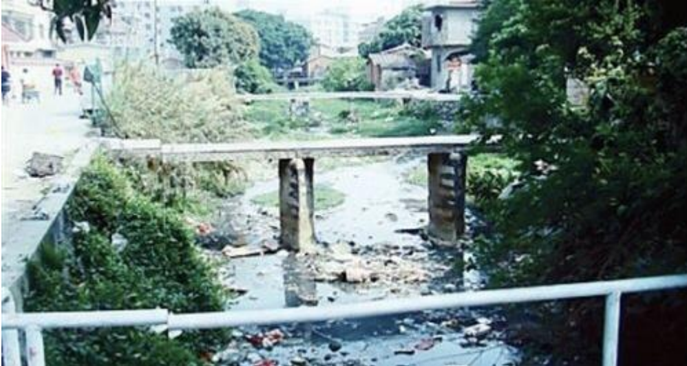
图7 治理前的锦坑沟
